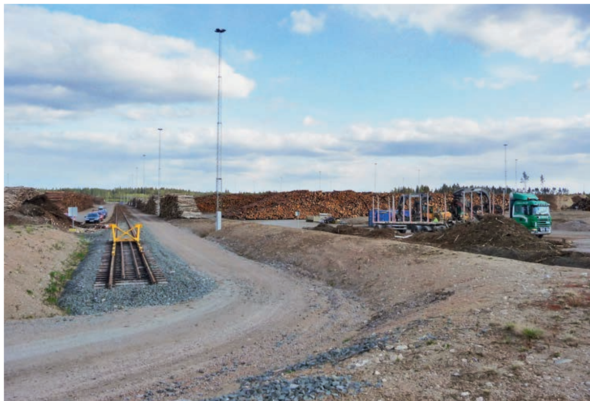
Abb 6 Bahnterminal in Stockaryd, Schweden: Auf dem Verladegleis können Ganzzüge mit 700 m Länge beladen werden. Foto: Peter Rauch
